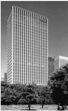
東京・汐留の新日通本社ビル
